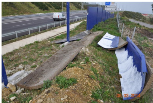
Ejemplos de barreras acústicas en malas condiciones.
