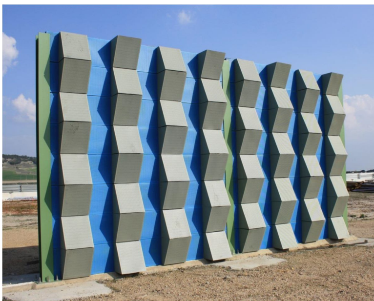
Foto: Muestras de pantalla acústica volumétrica altamente absorbente
