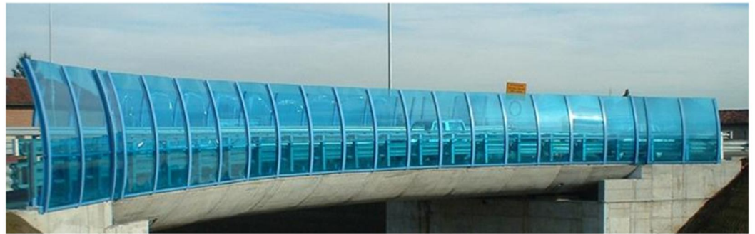
Foto: Optimización de las pantallas acústicas mediante su geometría
