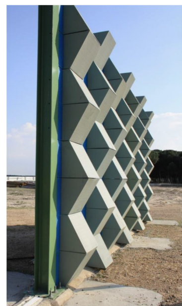
Foto: Muestras de pantalla acústica volumétrica altamente absorbente
